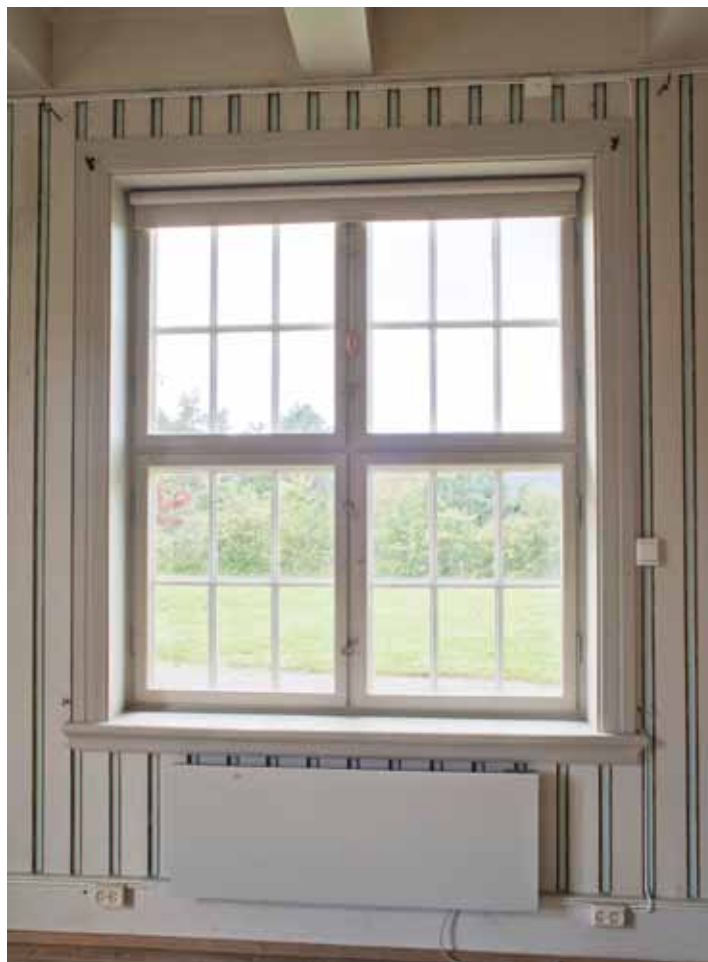
Over: Vindu mot vest, med varevindu.
