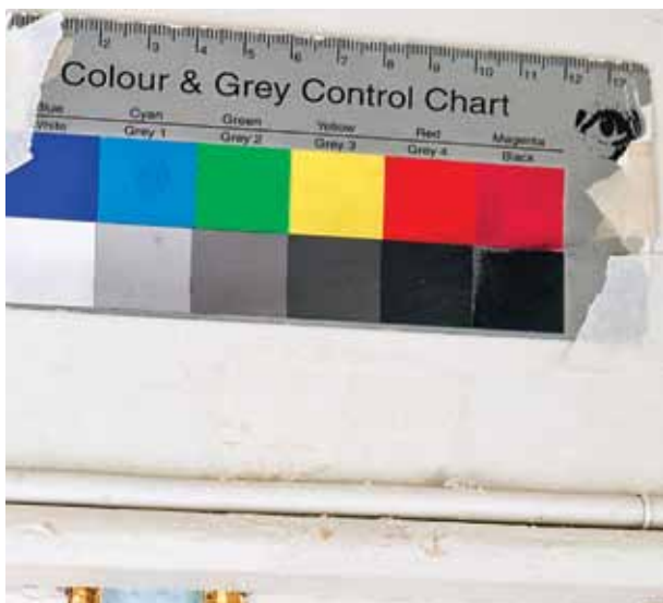
TAKLIST/BÅND AVSLUTNING NORD Til venstre for brannmur (Vestre del av veggen)
